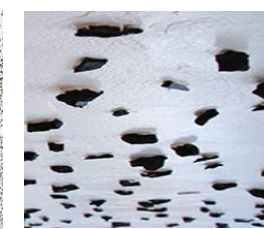
黒い炭片を天井にランダムに張り付けている部分のアップ
