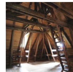
2階上部 小屋裏部屋（非公開） 那須塩原市HPより
