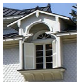
右側建物2階 ハンマービームトラス の手法による出窓
